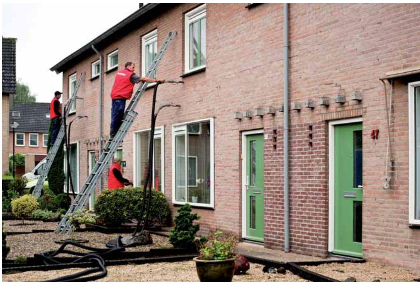
Spouwmuurisolatie en onderhoudswerkzaamheden
